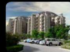
ATS PRELUDE Dera Bassi
